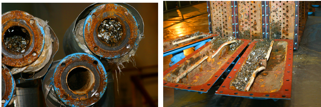
Рис. Фільтри на об'єктах водоподачі Хмельницької АЕС забиті дрейсеною річковою - Dreissena polymorpha L.
