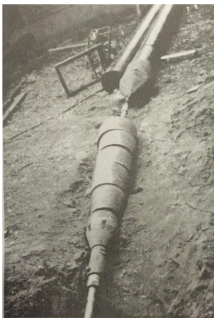
Рис. 1. Раскатчик скважин РТ-470 с закрепленной в хвостовой части трубной плетью для протаскивания в горизонтальную скважину
