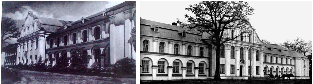
Рис. 4. Навчальний корпус № 1. Фото 1927-1930 рр.
